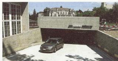
Cityparking Brühlort, Ein- und Ausfahrt Torstrasse.
